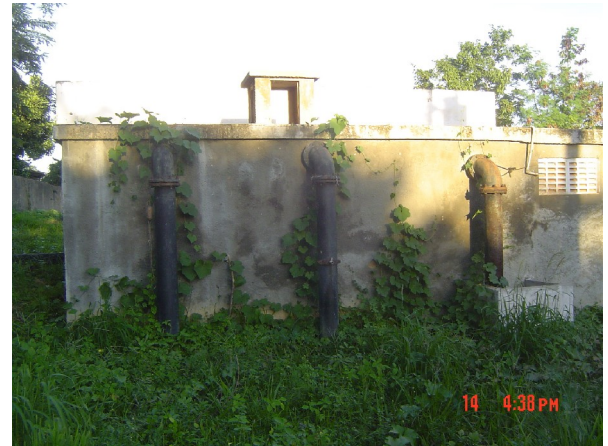
FIGURA 14. Reservatório Apoiado RA-02.
