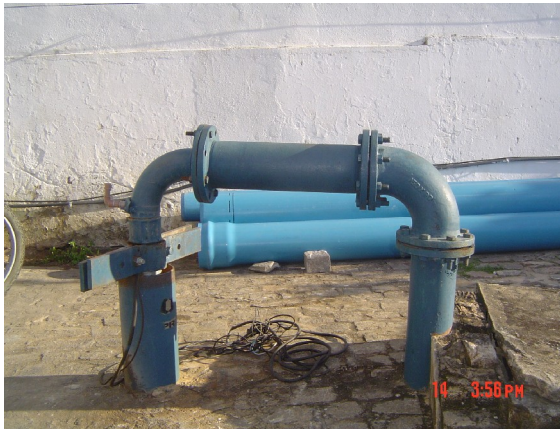
FIGURA 05. P01 de Parnamirim localizado na área da unidade de serviços, no Centro.
