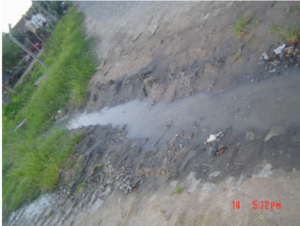
FIGURA 52. Lançamento de água servida em via pública, Conjunto Agnelo Alves.
