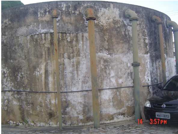
FIGURA 13. Reservatório Apoiado RA-01.
