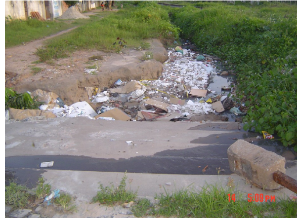
FIGURA 49. Disposição de lixo em erosão pluvial na Rua da Refesa, Conjunto Agnelo Alves.
