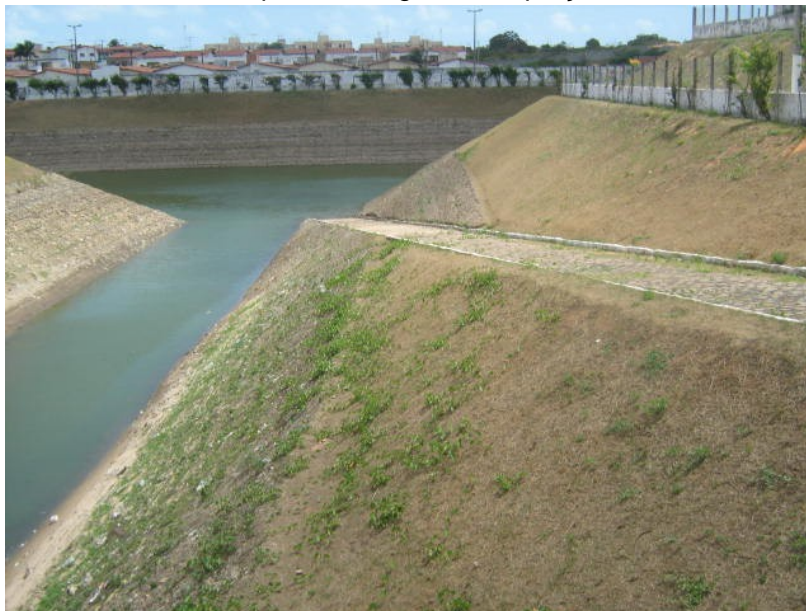
FIGURA 38. Limpeza da Lagoa de Captação Nezinho Alves.
