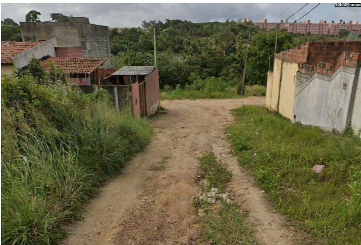
Figura 14 – Rua Caminho do Pescador – Loteamento Caminho do Atlântico – Cajupiranga – Parnamirim – RN
