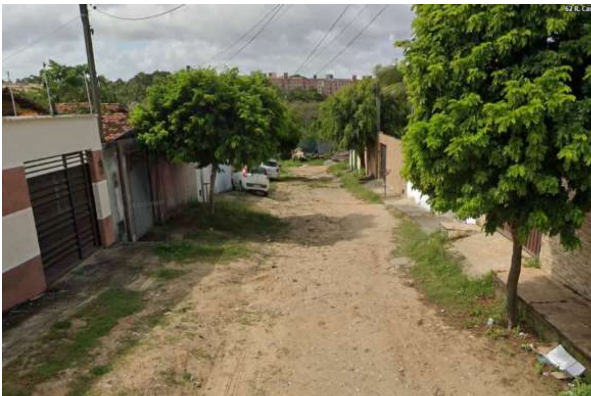
Figura 07 – Rua Caminho das Lagoas – Loteamento Caminho do Atlântico – Cajupiranga – Parnamirim – RN
