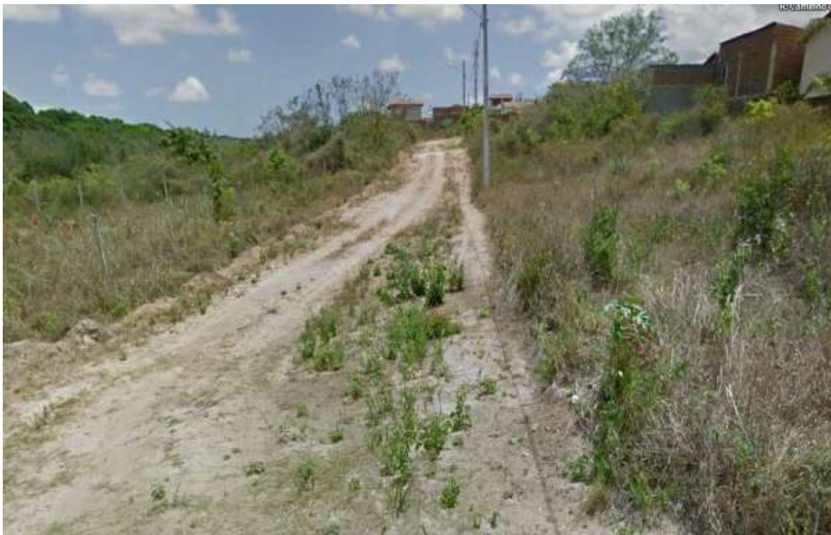
Figura 13 – Rua Caminho do Mato – Loteamento Caminho do Atlântico – Cajupiranga – Parnamirim – RN
