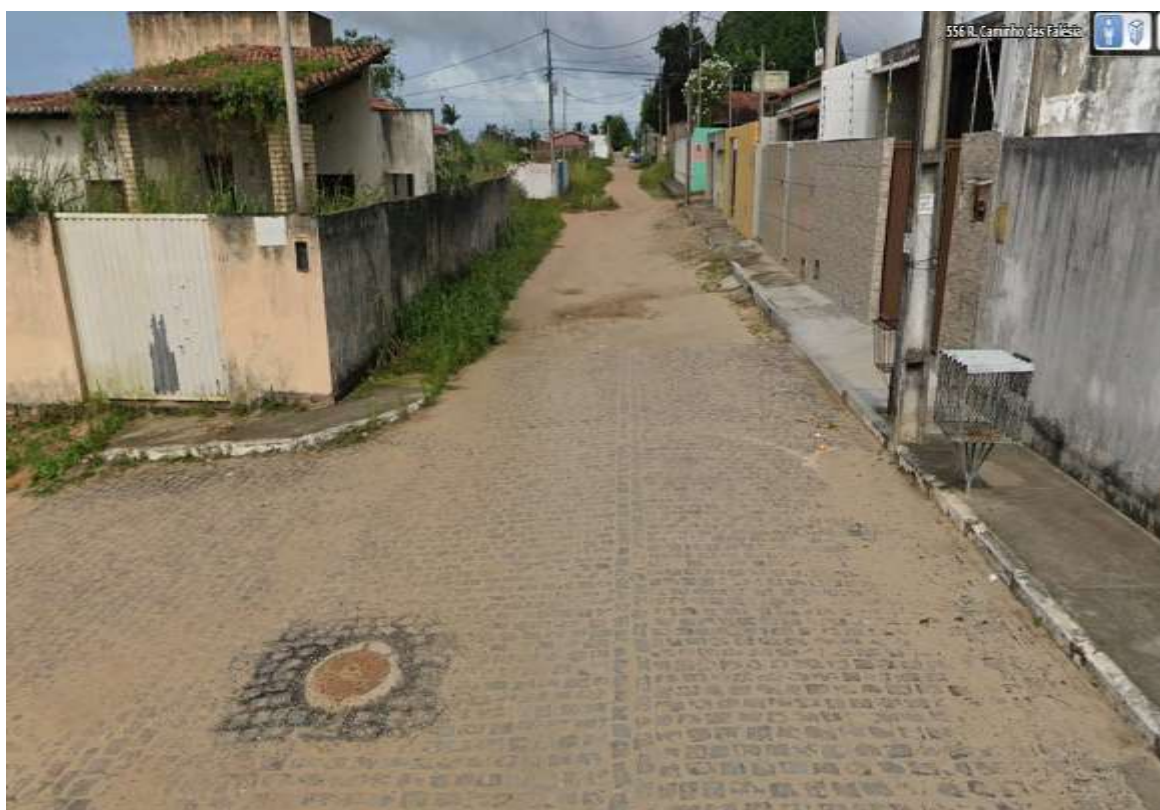
Figura 06 – Rua Caminho das Falésias – Loteamento Caminho do Atlântico – Cajupiranga – Parnamirim – RN
