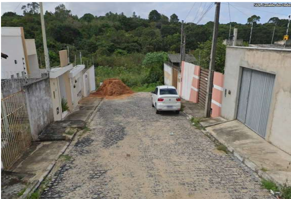
Figura 10 – Rua Caminho das Ondas – Loteamento Caminho do Atlântico – Cajupiranga – Parnamirim – RN
