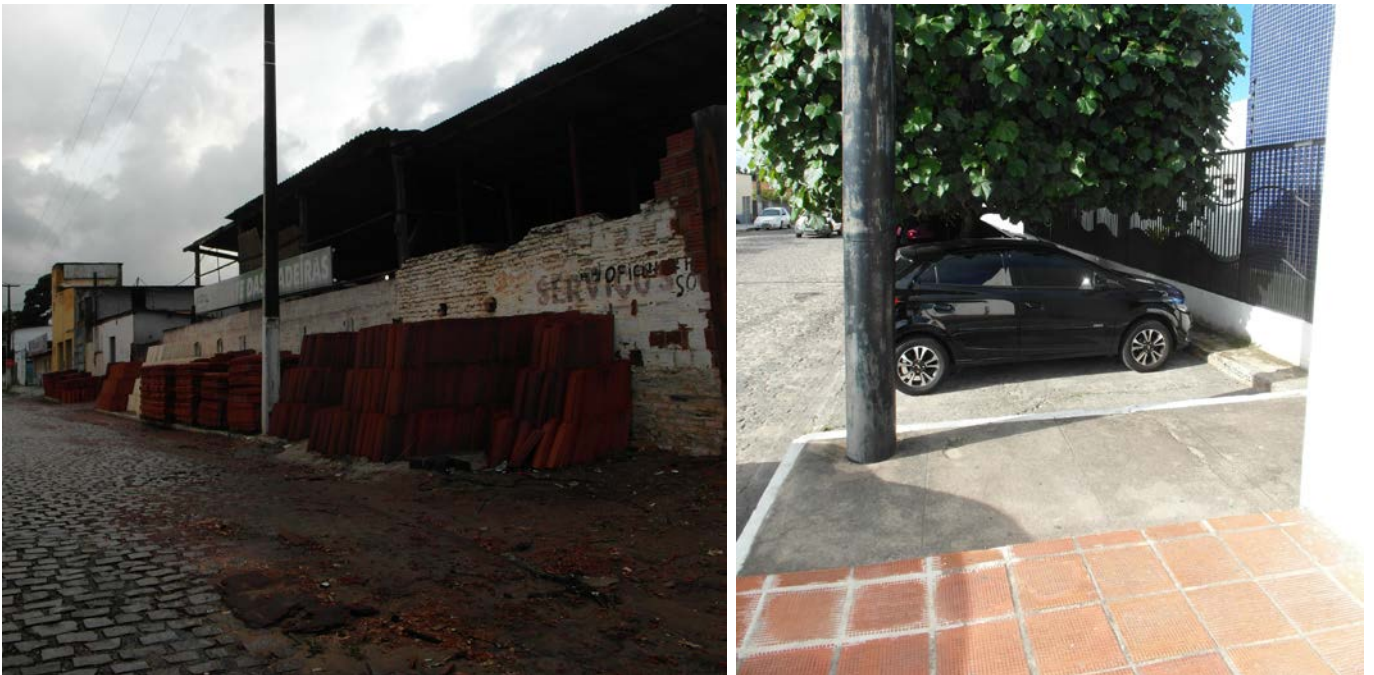
Figura 12. Descontinuidades no passeio público – avanço/ocupação da calçada - exemplos
