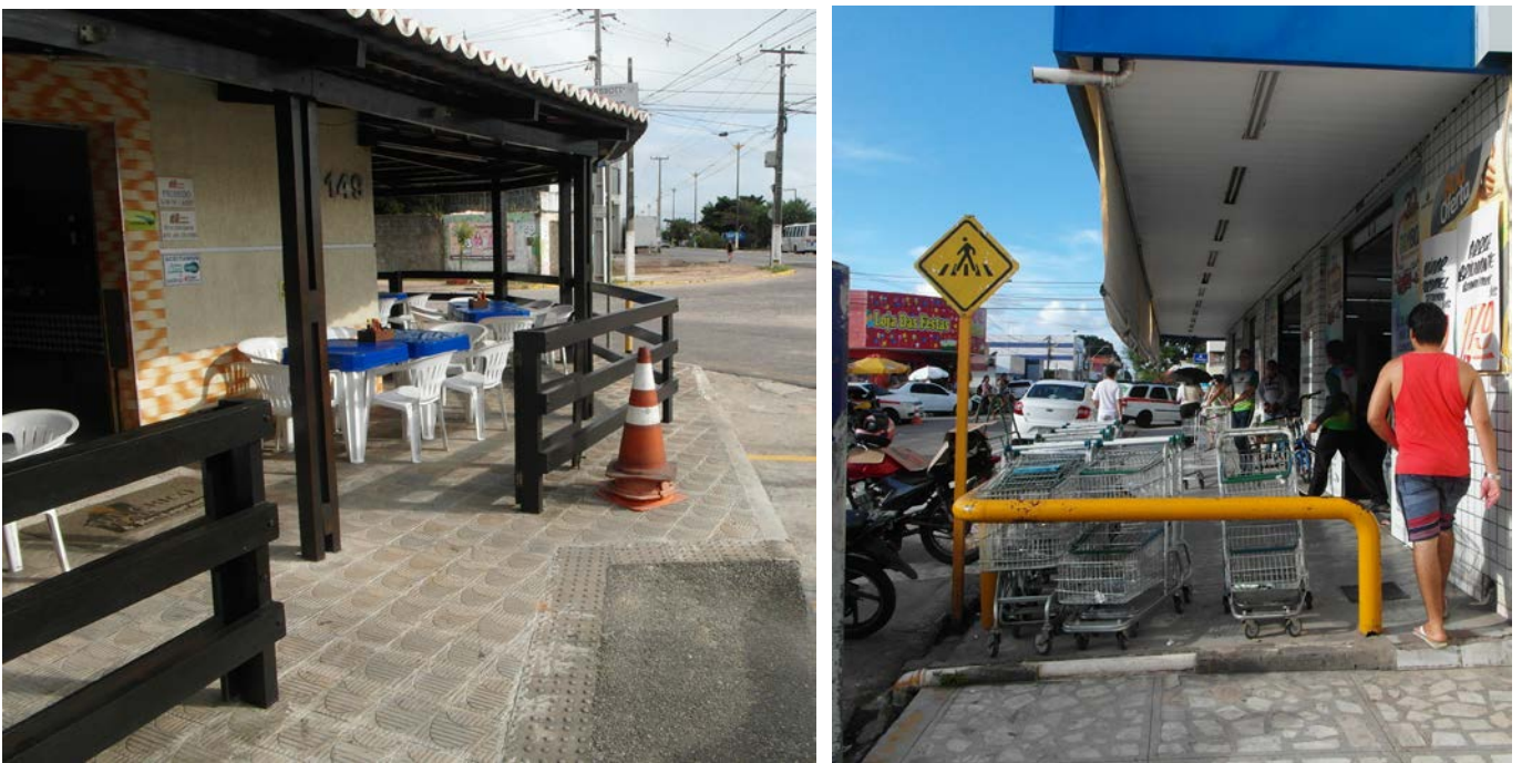
Figura 13. Descontinuidades no passeio público – avanço/ocupação da calçada - exemplos
