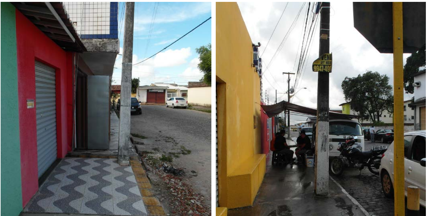
Figura 11. Descontinuidades no passeio público – avanço/ocupação da calçada - exemplos
